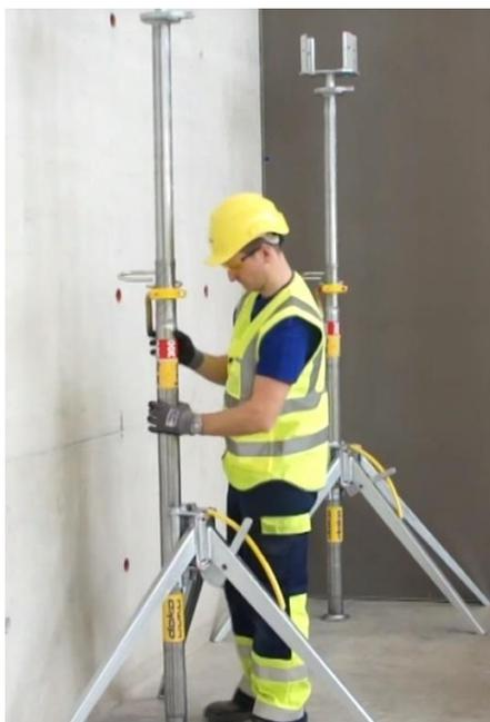
Рисунок 3.3 – Устройство крепления удерживающей треноги и опорной стойки
