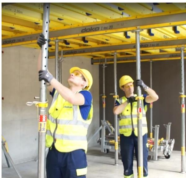
Рисунок 3.6 – Монтаж промежуточных стоек
