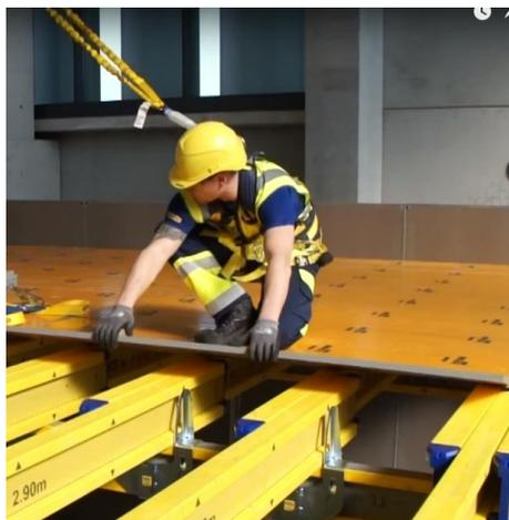
Рисунок 3.5 – Монтаж палубы (элемента настила)
