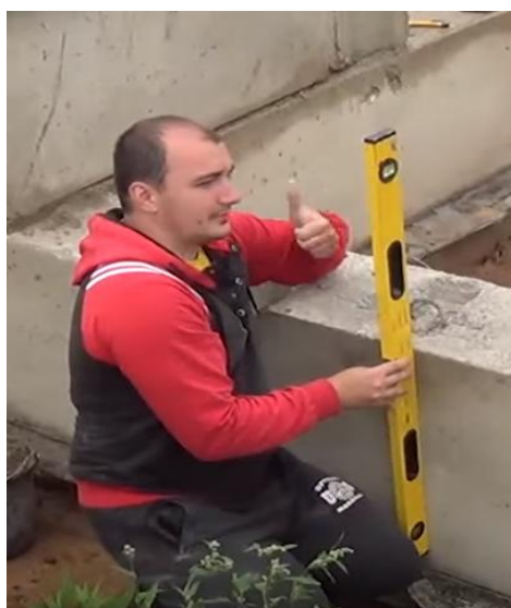
Рисунок 3.4 – Выверка блока
