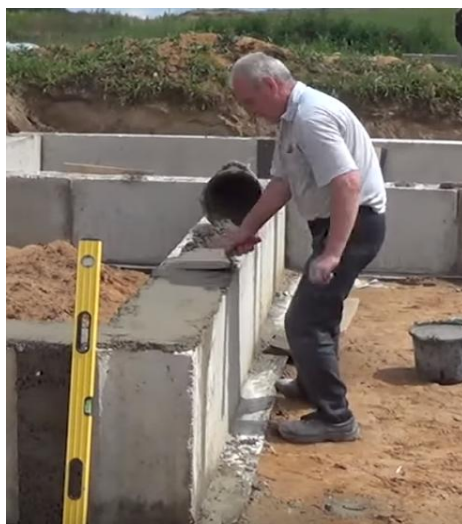
Рисунок 3.3 – Разметка места укладки блока
