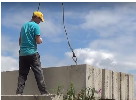
Рисунок 3.1 – Строповка блока
