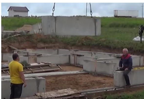
Рисунок 3.2 – Подача блока к месту укладки (М1, М4, строп)
