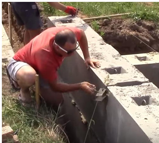
Рисунок 3.5 – Заделка швов
