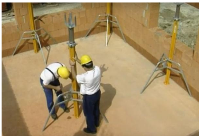
Рисунок 3.6 – Крепление стойки с треногой
