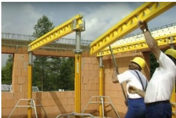
Рисунок 3.7 – Монтаж продольных балок
