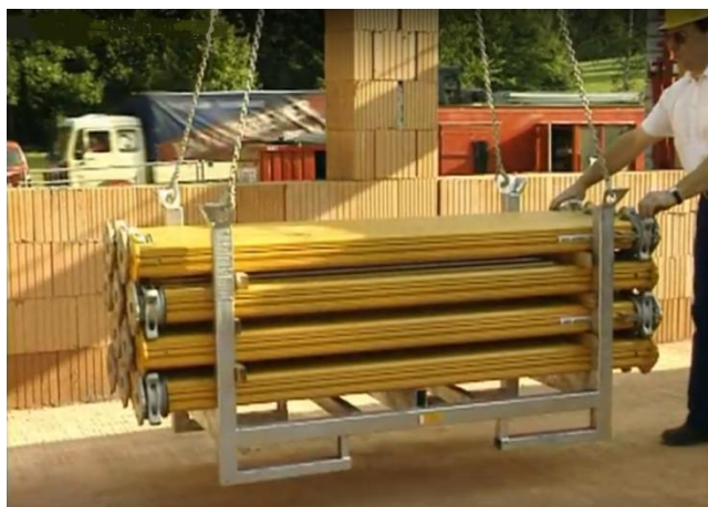
Рисунок 3.4 – Подача элементов опалубки к месту монтажа
