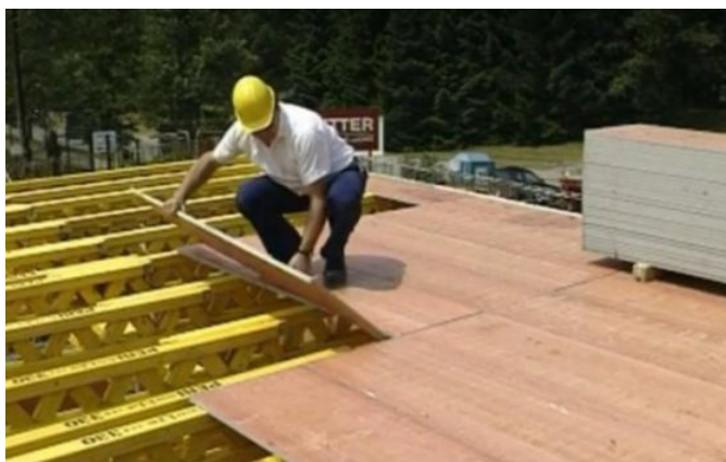
Рисунок 3.9 – Монтаж палубы (элемента настила)
