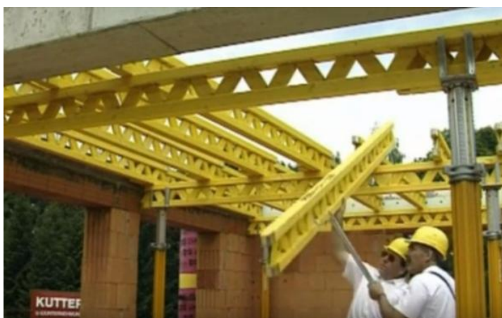
Рисунок 3.8 – Монтаж поперечных балок
