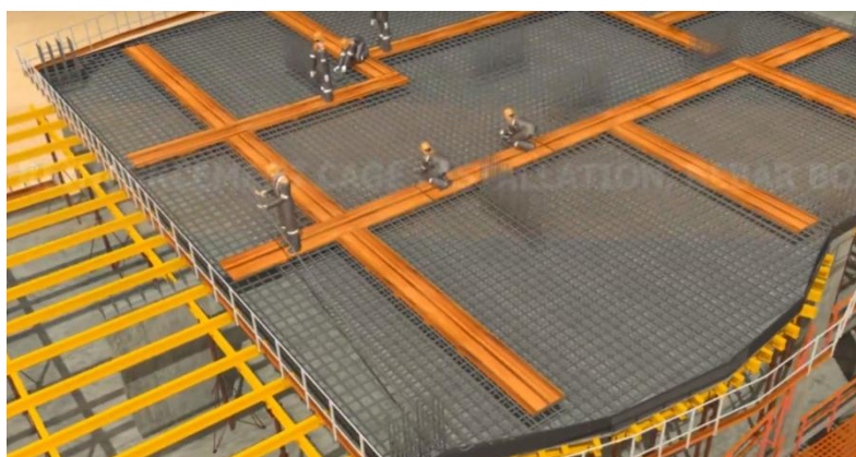
Рисунок 3.13 – Организация рабочего места арматурных работ
