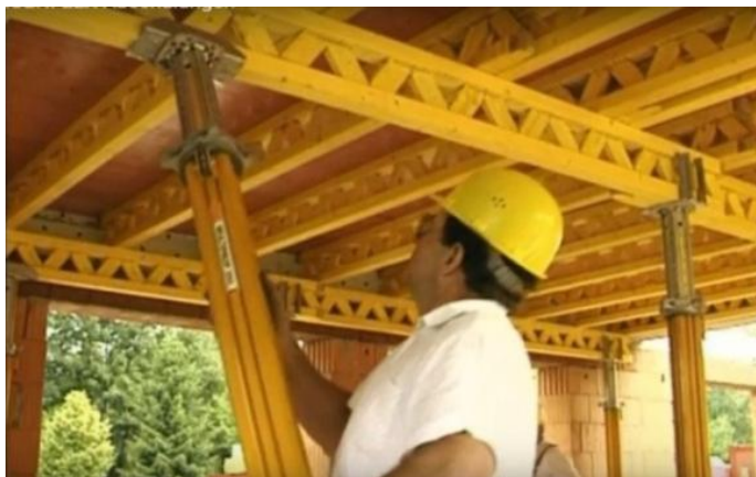
Рисунок 3.10 – Монтаж промежуточных стоек
