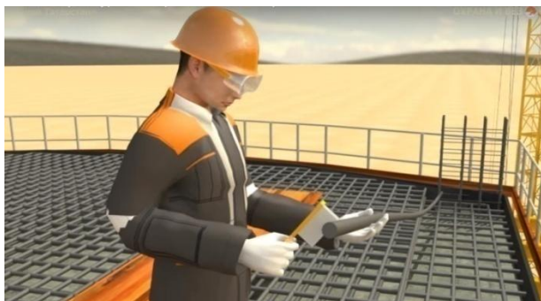
Рисунок 3.11 – Очистка арматурных изделий
