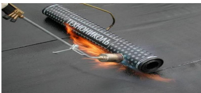
Рисунок 3.5 – Укладка гидроизоляционного слоя по огрунтованной поверхности
