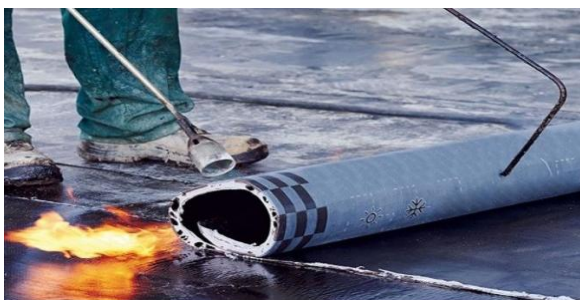
Рисунок 3.1 – Укладка пароизоляционного слоя из Бикроэласта ЭПП
