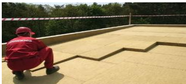
Рисунок 3.3 – Устройство теплоизоляционных плит
