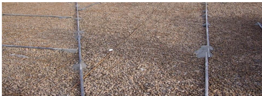
Рисунок 3.2 – Разуклонка кровли керамзитобетоном
