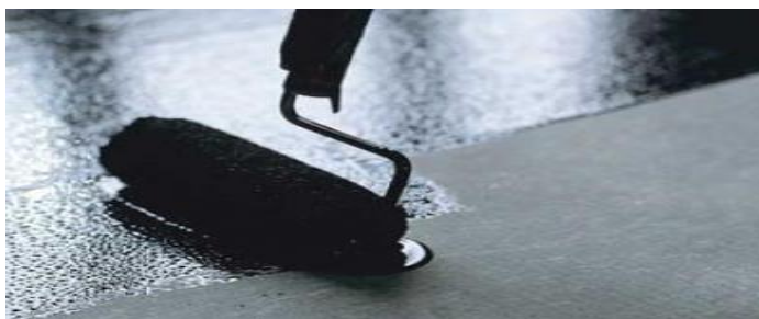
Рисунок 3.4. Огрунтовка поверхности битумным праймером
