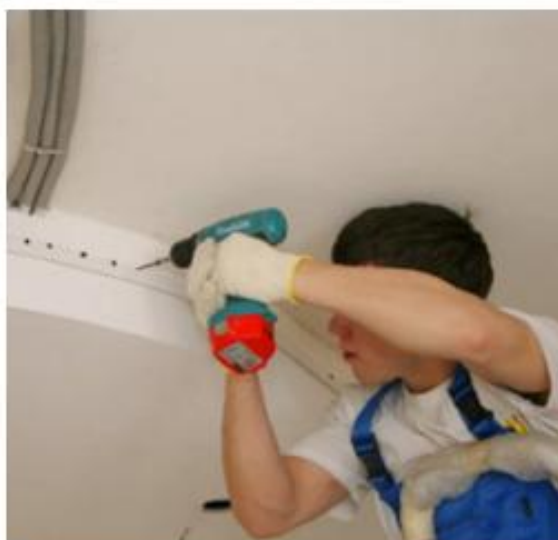
Рисунок 3.3 – Крепление ПВХ профиля на стену
