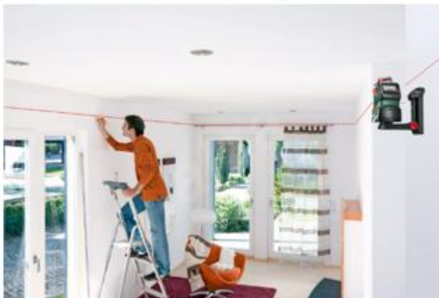
Рисунок 3.2 – Разметка уровня размещения натяжного потолка помощью лазерного уровня
