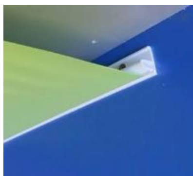
Рисунок 3.6 – Крепление ПВХ полотна в багет
