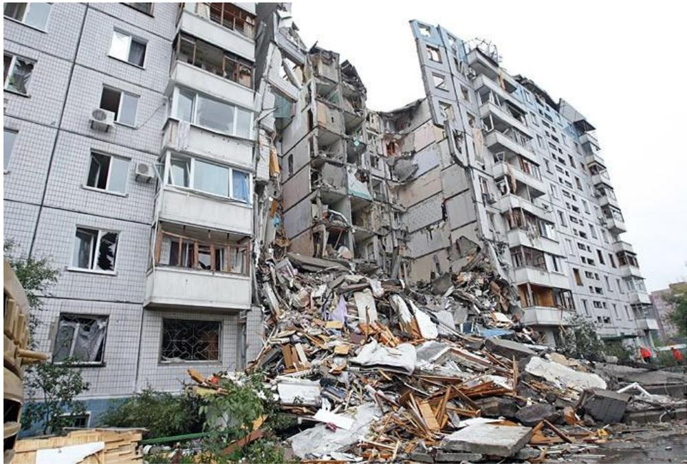
Рисунок 1.2 –Характер разрушений части крупнопанельного здания после землетрясения [38]
