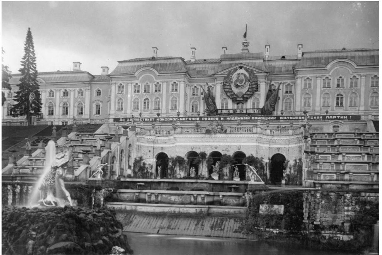
Рисунок 1.14 – большой каскад после реставрации
