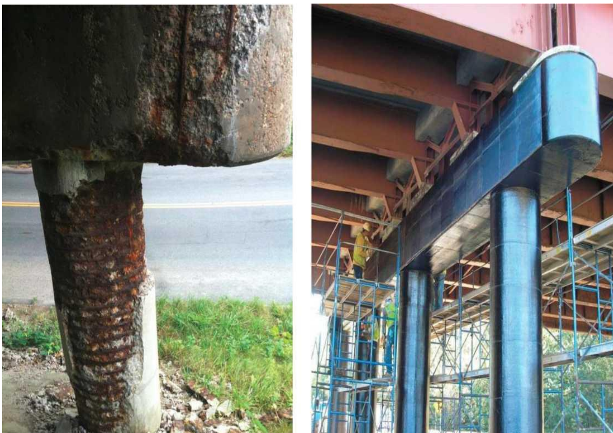
Рисунок 1.13 – Восстановление железобетонных конструкций композитными материалами
