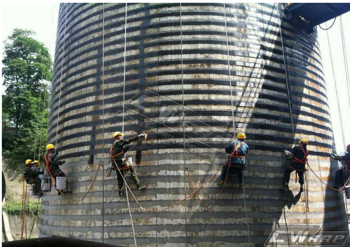
Рисунок 1.14 – Процесс усиление железобетонных конструкций композитными материалами
