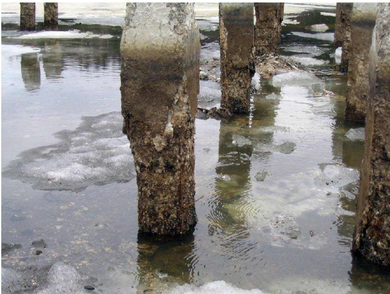
Рисунок 1.2 – Коррозия железобетона
