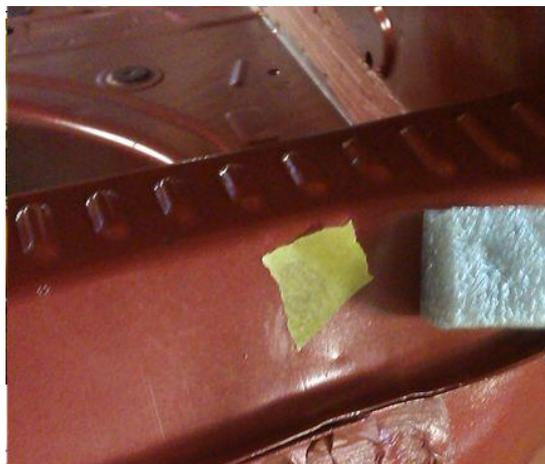
Рис.21 Вмятина обшивки задней панели
