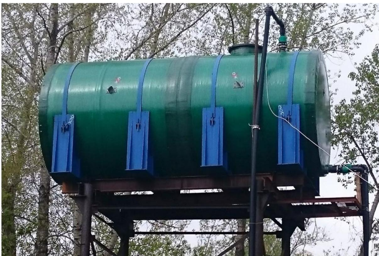
Рисунок 4.12 – Смонтированная стеклопластиковая емкость
