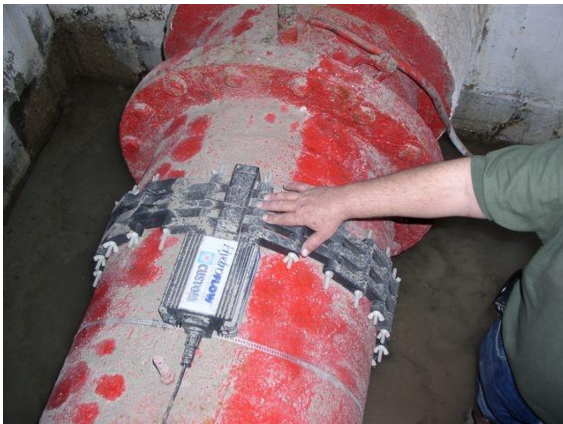
Рисунок 3.1 – установка электромагнитного устройства на трубопровод Подобрано устройство «ферритного» типа Гидрофлоу Кастом 18". Передача энергии электромагнитного поля в воду осуществляется с помощью
