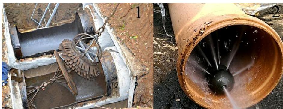
1 – механическая очистка; 2 – гидродинамическая очистка
