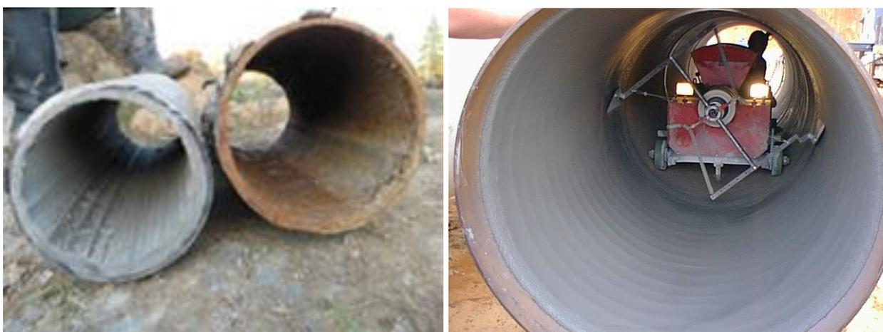
Рисунок 3.1 – Фрагменты труб с нанесенным цементно-песчаным покрытием
