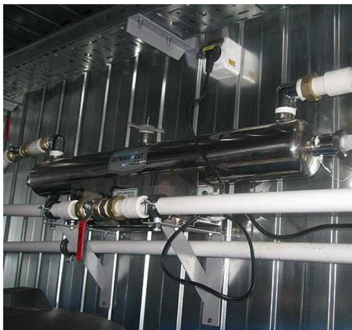
Рисунок 2.14 – Фото установки для УФ - обеззараживания воды
