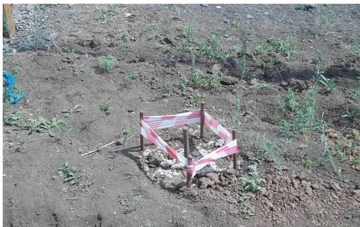
Рисунок 3.1 – Установленный репер
