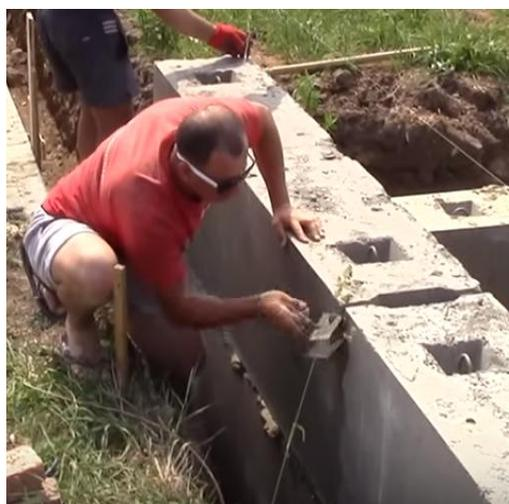
Рисунок 3.9 – Заделка швов
