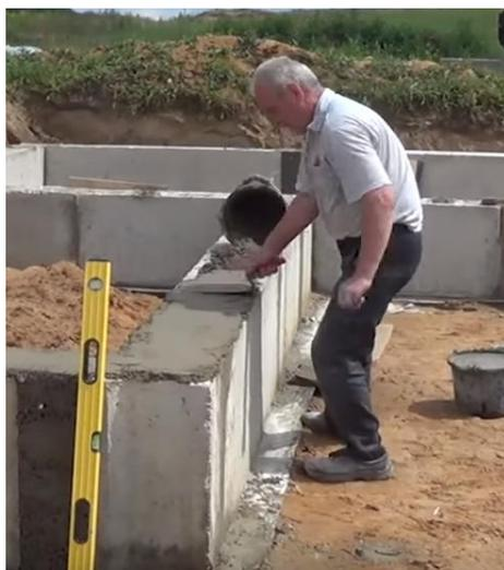
Рисунок 3.7 – Разметка места укладки блока
