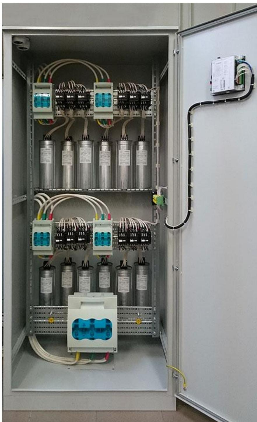
Рисунок 13 – Установка для компенсации РМ с авторегулированием
