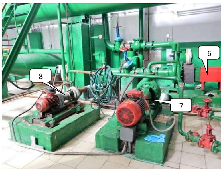
Рисунок 7 – Общий вид размещения насосных агрегатов
