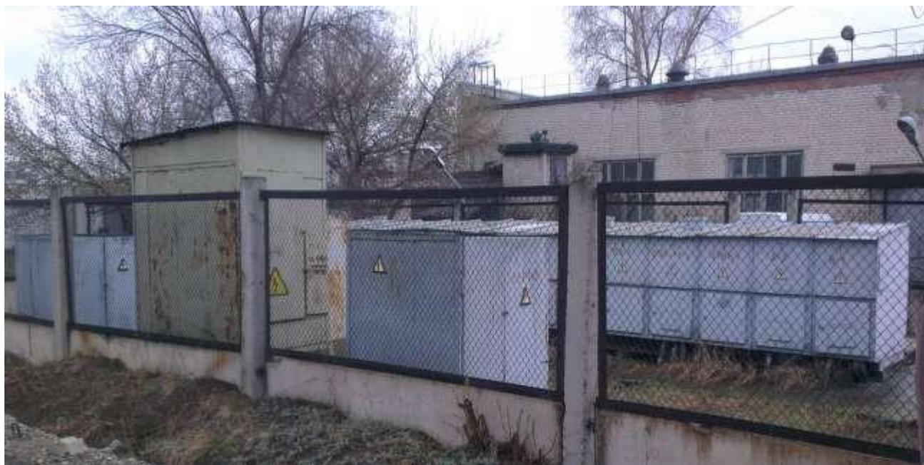
Рисунок 9 – Комплектное распределительное устройство, КРУН 6 кВ
