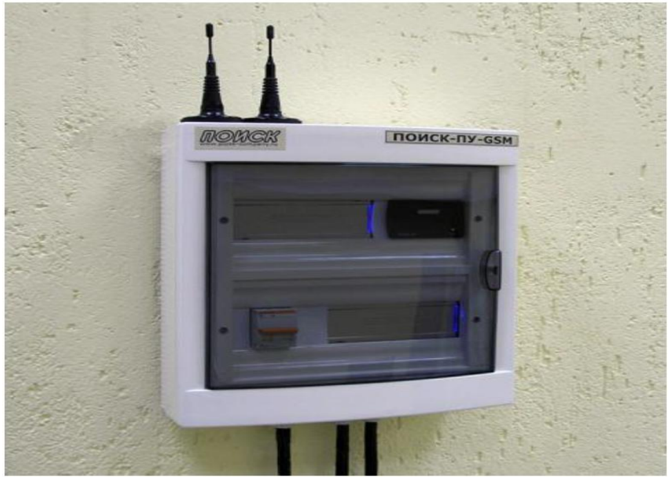
Рисунок 9 - Устройство пункта управления ПУ-GSM
