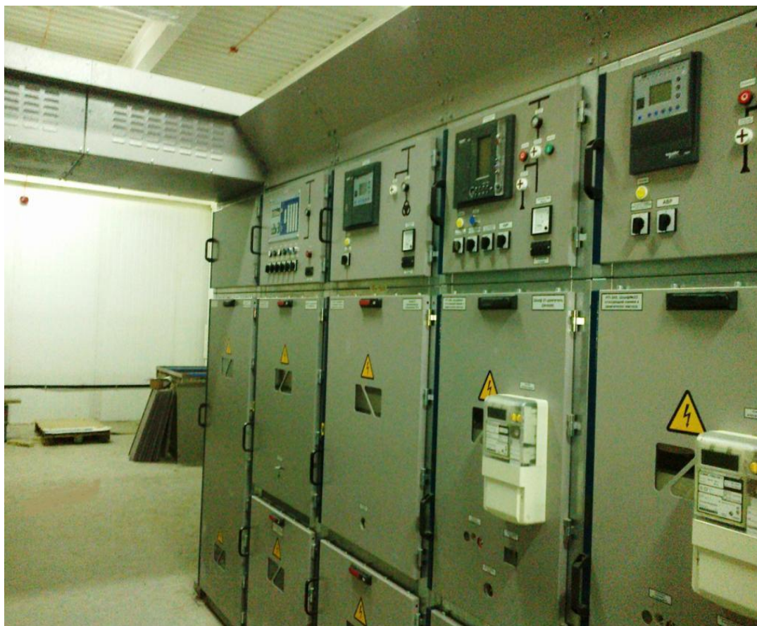
Рисунок 5 - Пример исполнения релейной защиты на ячейке типа КРУ
