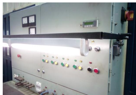
Рисунок 42- а) нерабочее положение светильника б) рабочее положение
