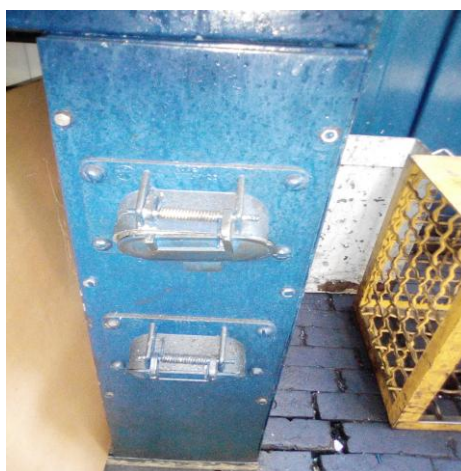
Рисунок 42 – Блок силовых розеток для проверки двигателей
