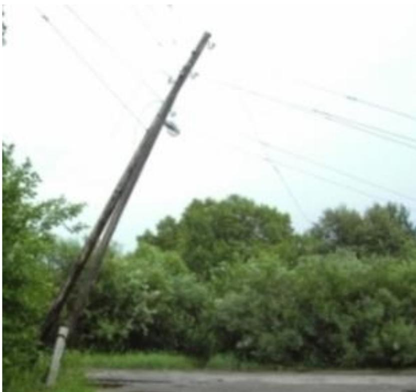
Рисунок 7 – Покосившаяся опора
