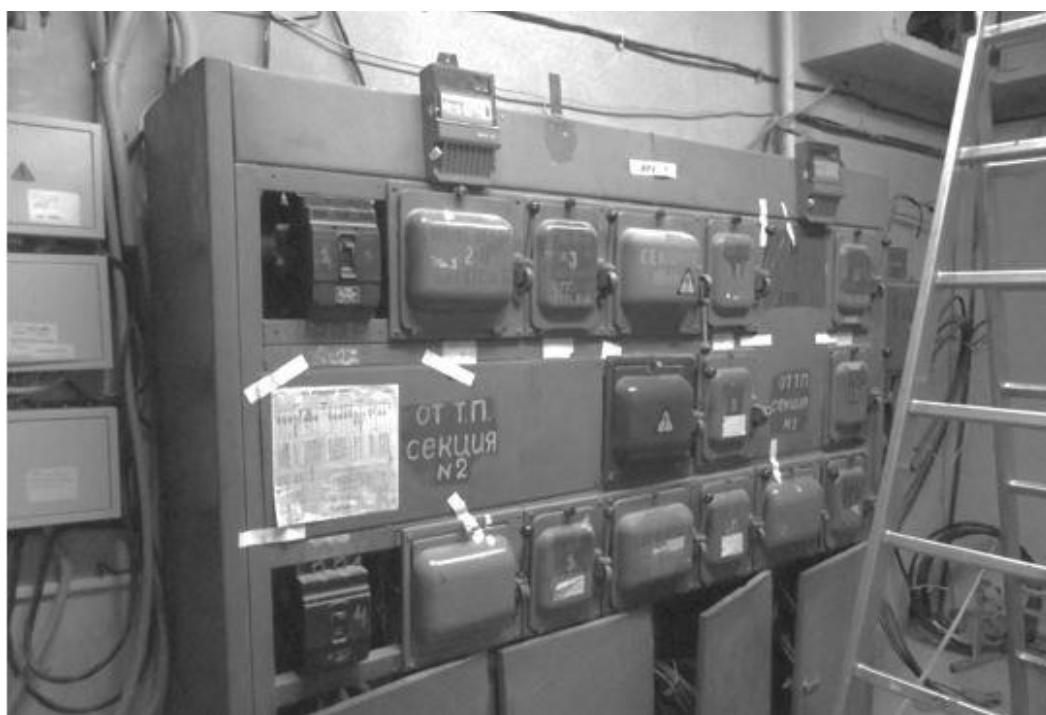
Рисунок 3.2 – Вводно – распределительное устройство №1
