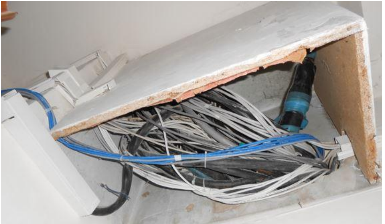
Рисунок 3.12 – Большое количество проводов в одном лотке
