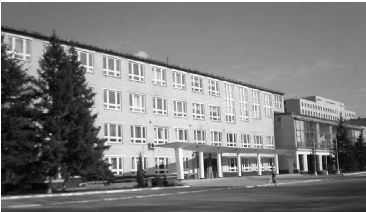
Рисунок 1.1 – Фасад главного корпуса
