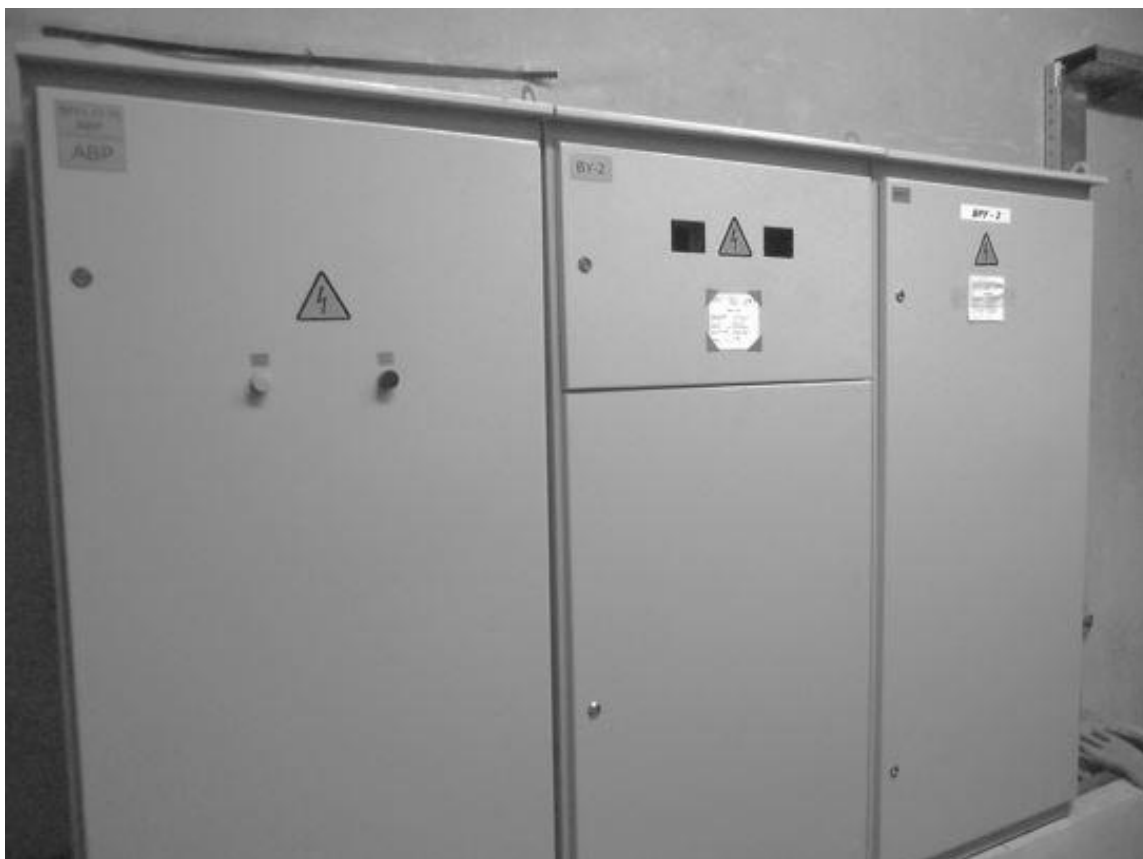
Рисунок 3.3 – Вводно-распределительное устройство №2
