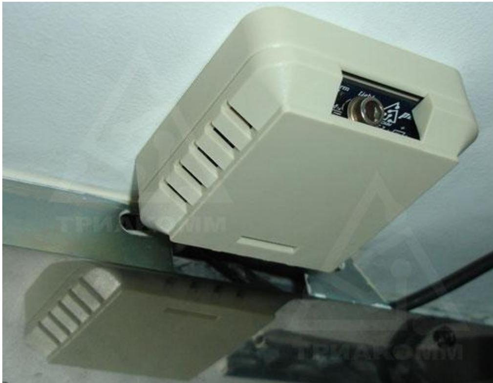
Рисунок 1.7 – Использование датчика света в автоматическом режиме управления жалюзи
