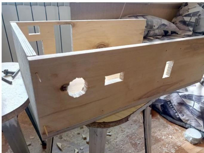
Рисунок 55 - Сделали черновые отверстия для электронных компонентов и двери. С позиционировали отверстия с помощью зубочисток. Просверлили нужные отверстия. Скрепили стены саморезами.
