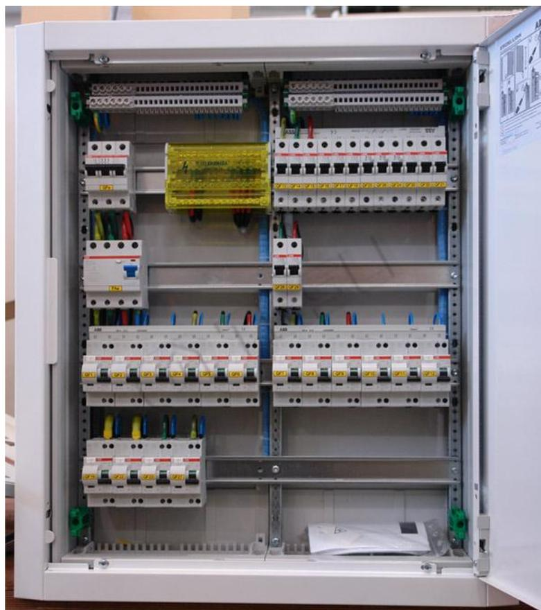
Рисунок 5.3 – Распределительный шкаф или щит освещения
