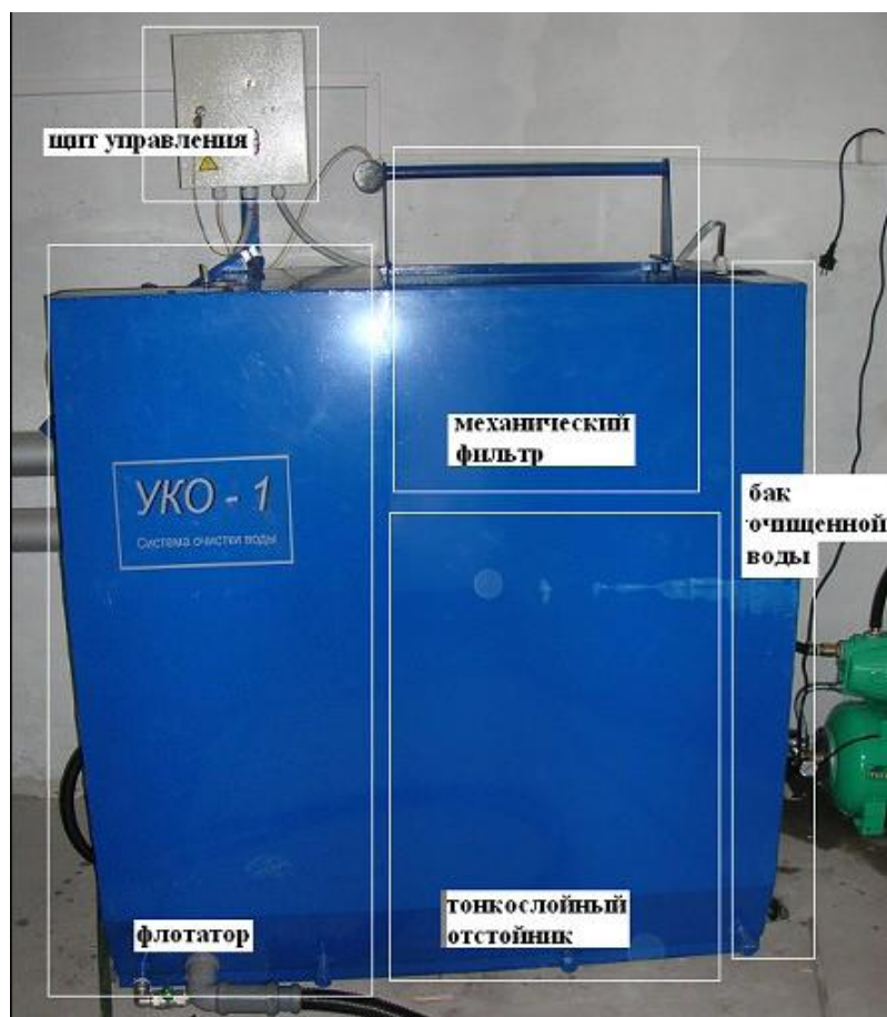
Рисунок 6.2 - Размещение агрегатов УКО-1
