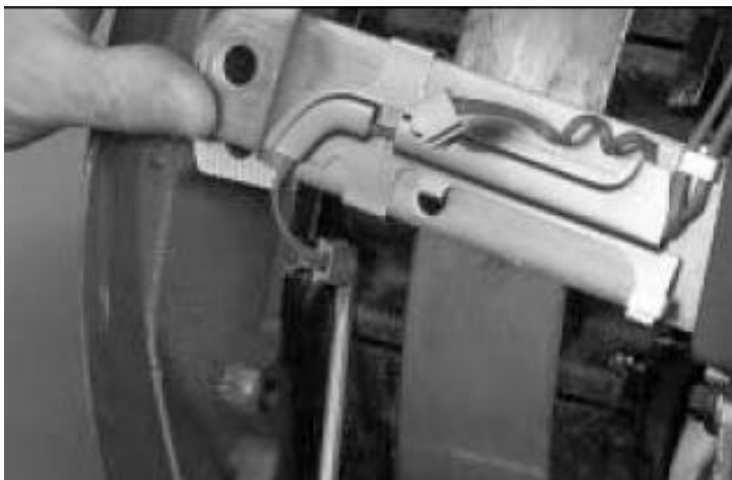
Рис. 3.3 Демонтаж держателя колодки
