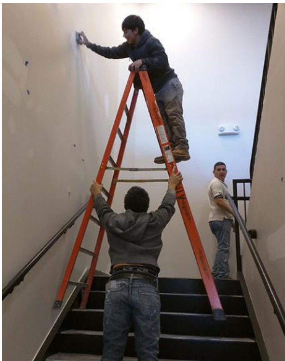
Рисунок 13 – неправильная работа с применением переносной стремянки на неровных поверхностях
