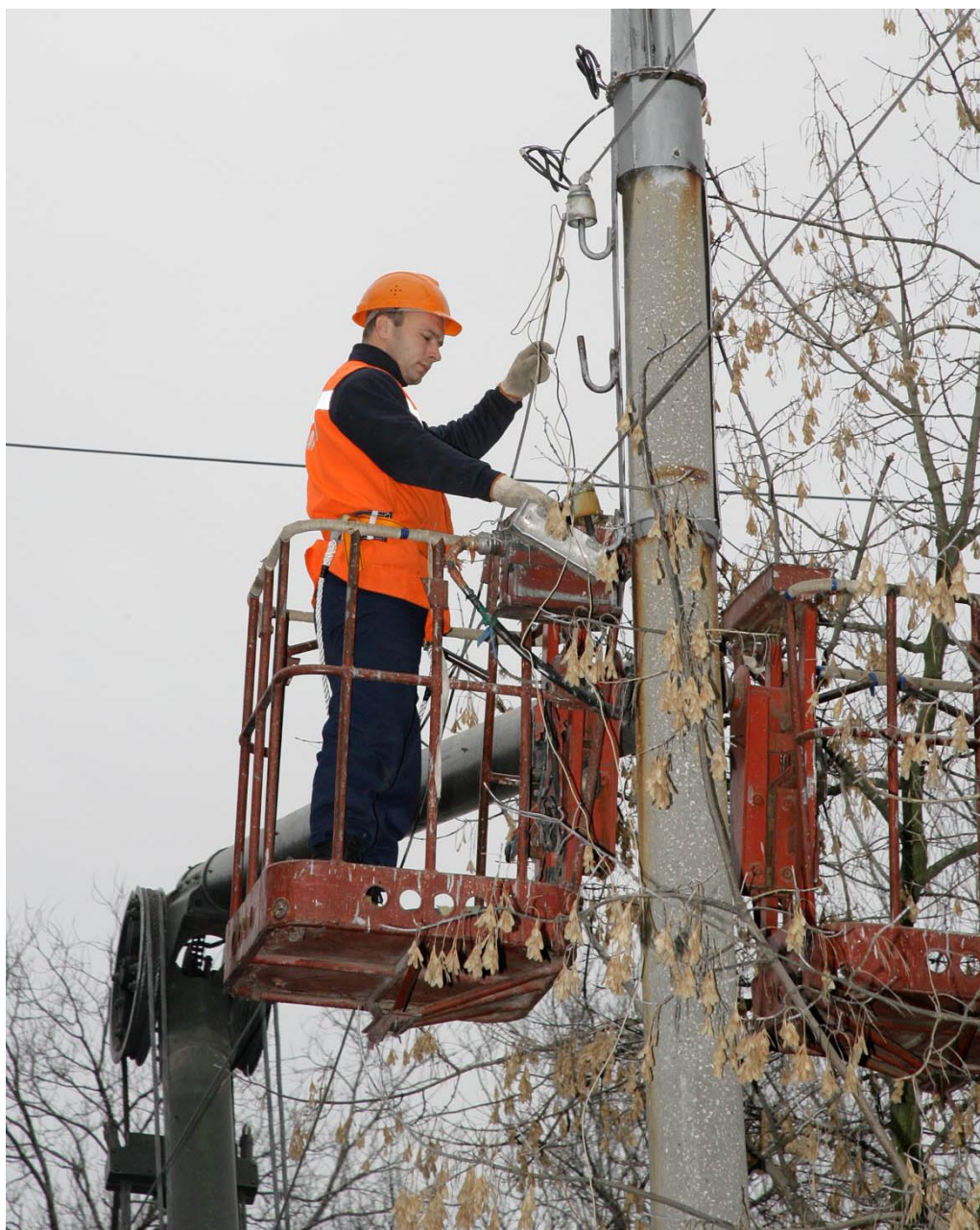
Рисунок 11 – Проведение работ на опорах ВЛС с использованием люльки подъемного механизма
