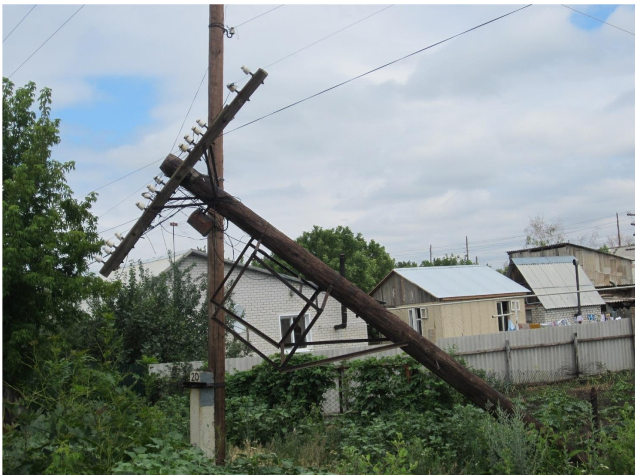
Рисунок 10 – Падение опоры ВЛС
