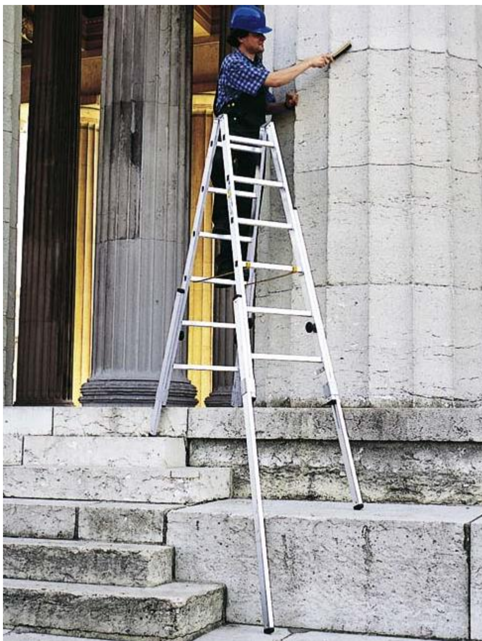
Рисунок 14 – Работа с применением лестницы с удлиняемыми опорными стойками
