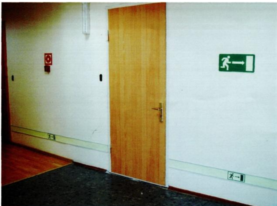
Рисунок 3.5 – Пример применения эвакуационной разметки
