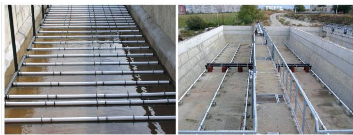
Рисунок 2.2 -Трубчатые аэрационные системы «Полипор»
