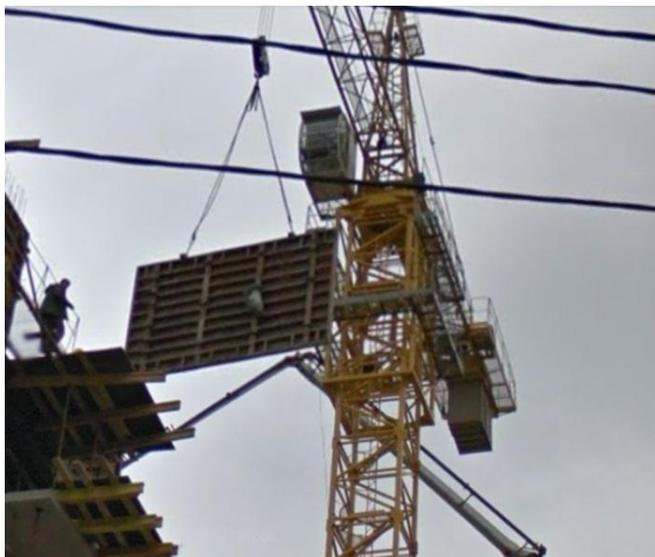
Рисунок 3.1 – Подъем опалубки к месту ее установки
