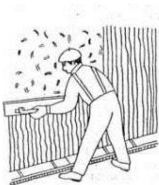
Рисунок 3.2 – Разравнивание грунта с помощью полутерков
