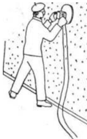
Рисунок 3.4–Механизированная затирка накрывочного слоя
