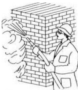
Рисунок 3.1 – Механизированное нанесение слоя обрызга с помощью растворонасоса
