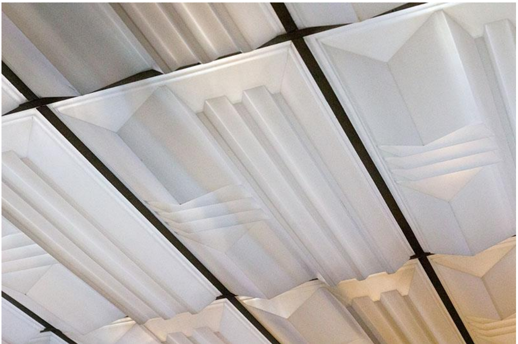
Рисунок А.4 – Пластиковый потолок «марлюкс»
