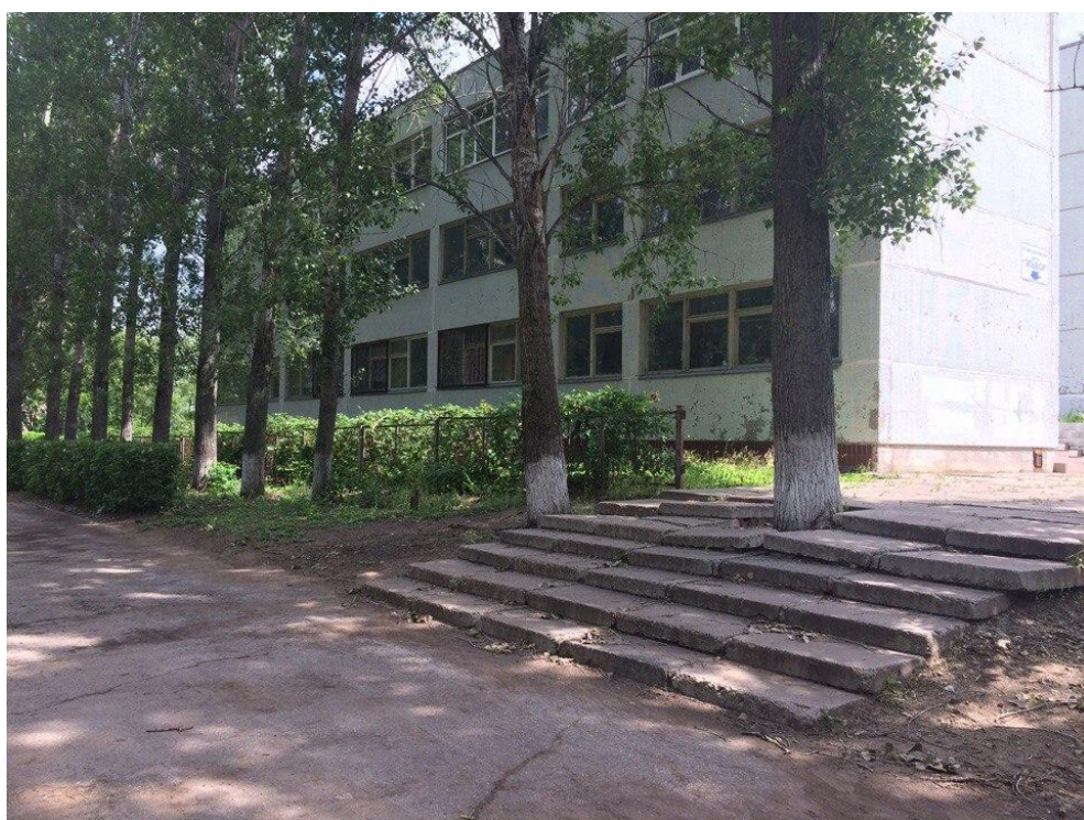
Рисунок 10 – Фотофиксация исходной ситуации, вид лестницу в школу №81
