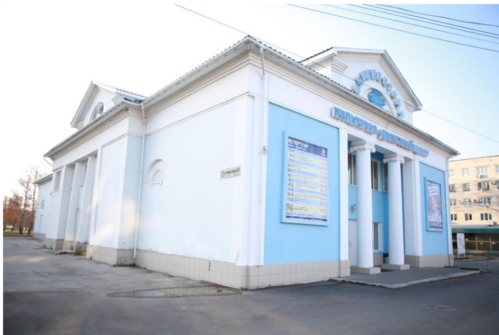
Рисунок 2 – Фотофиксация территории, 2018г., вид на фасад
