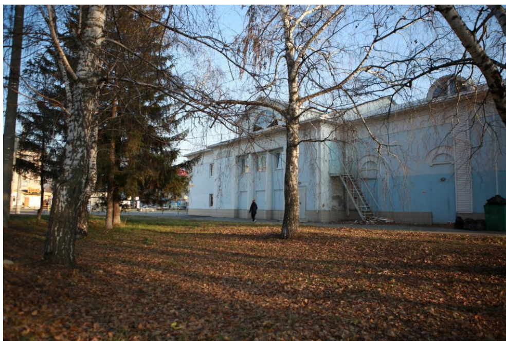
Рисунок 3 – Фотофиксация территории, 2018г., вид на правую сторону здания
