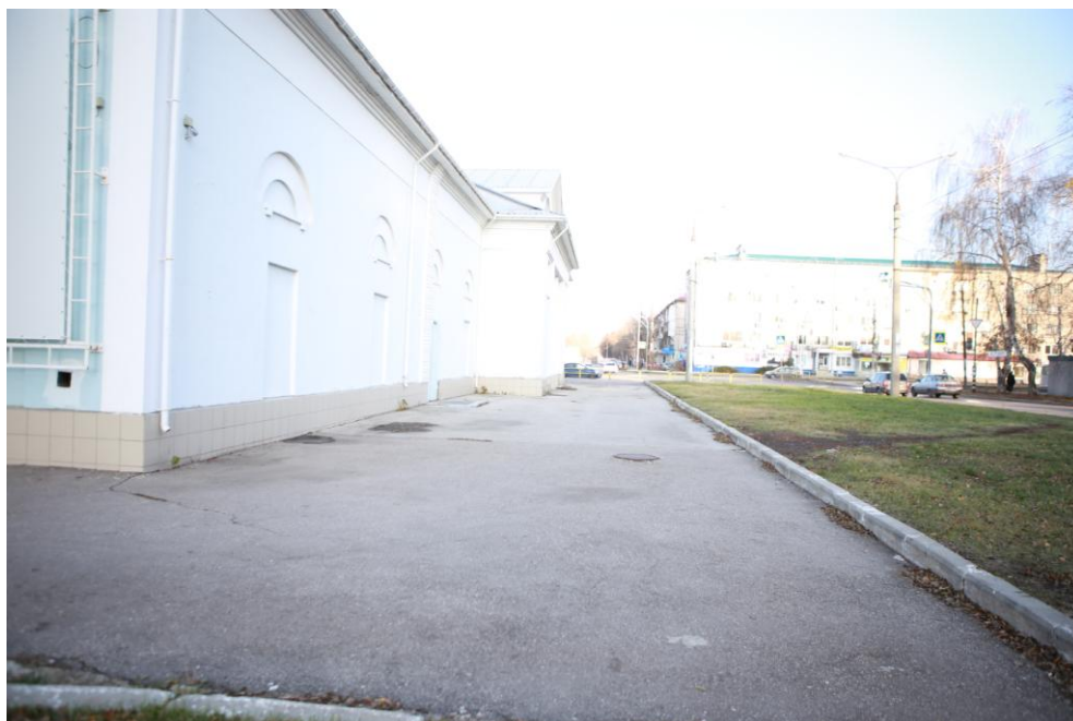
Рисунок 4 – Фотофиксация территории, 2018г., вид на левую сторону здания
