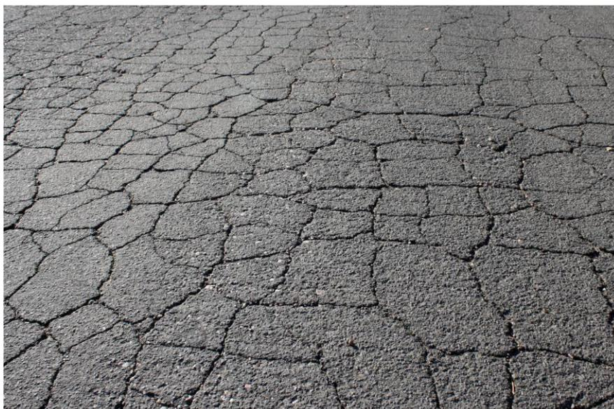
**Рисунок 4 – Мелкая сетка трещин**
