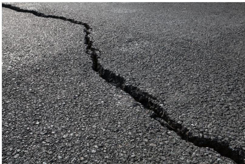
**Рисунок 3 – Одиночная трещина**
