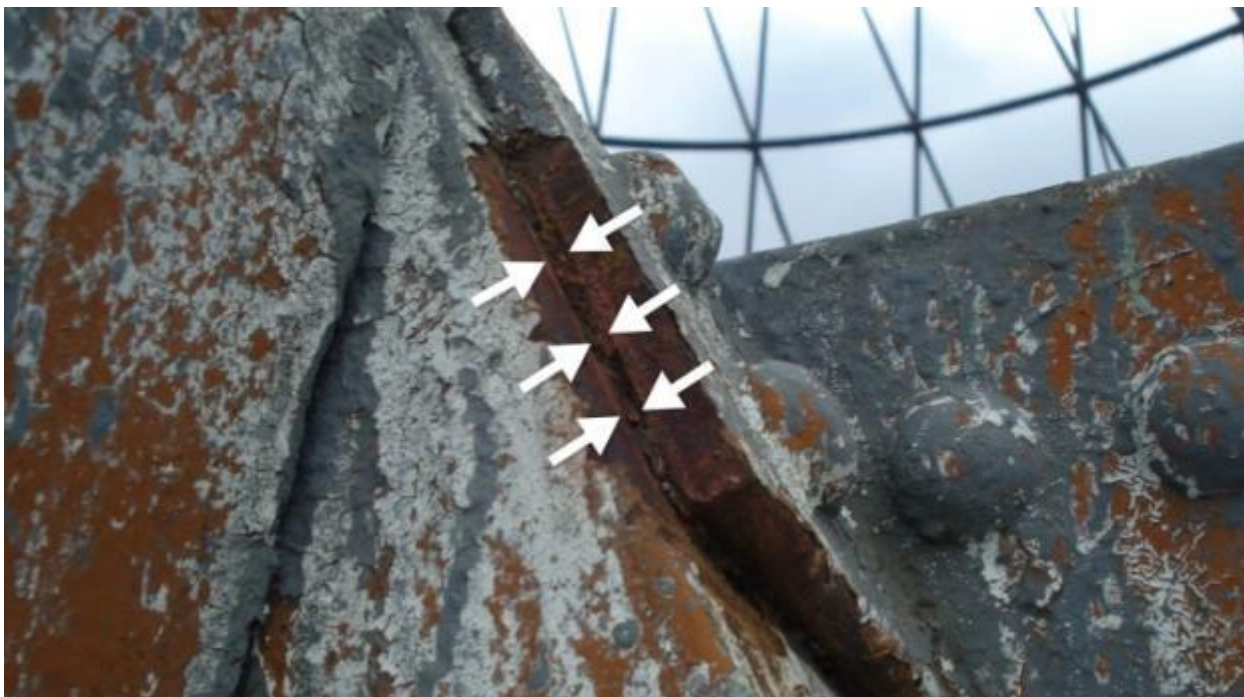
Рисунок 1 – Щелевая коррозия
