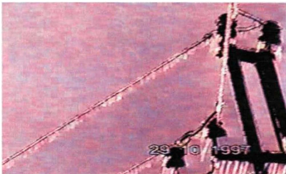
Рисунок 3.9 - Согнутая опора под нагрузкой гололеда
