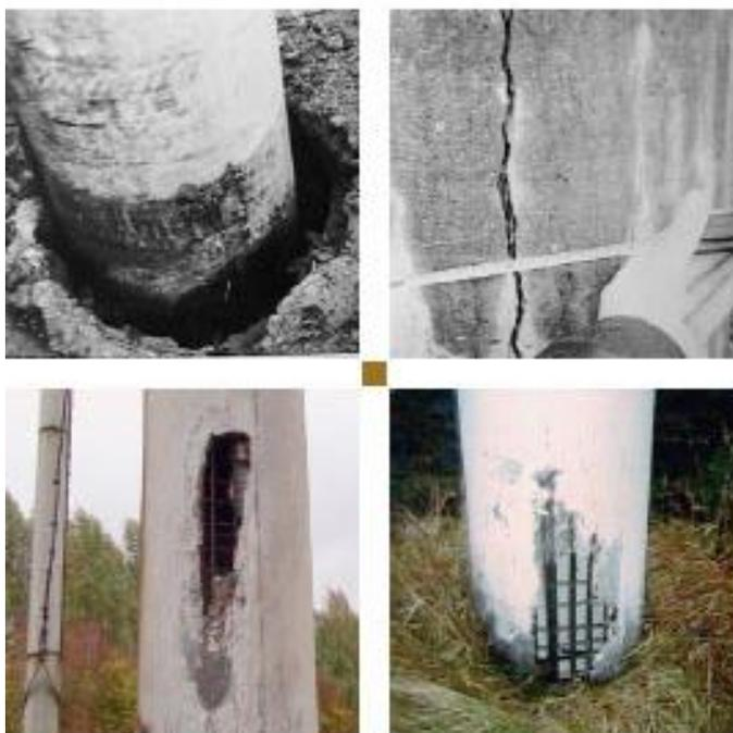
Рисунок 1.5 – Характерные разрушения железобетонных опор
