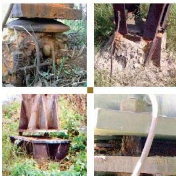
Рисунок 1.4 – Характерные разрушения фундаментов металлических опор
