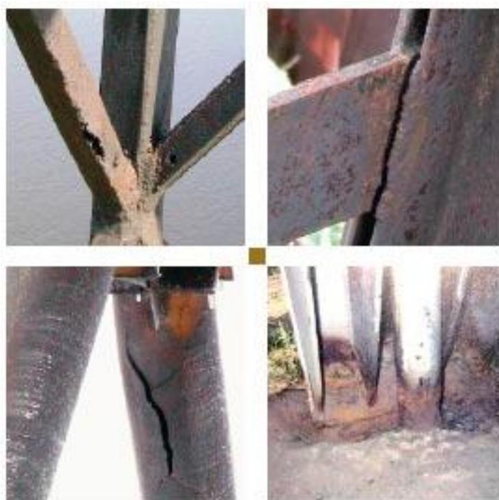
Рисунок 1.3 – Характерные разрушения металлических опор
