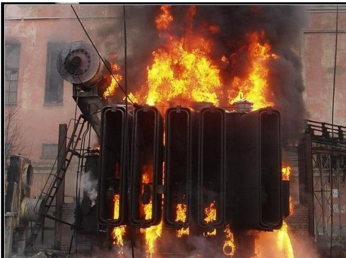
Рисунок 12 – Пожар силового трансформатора
