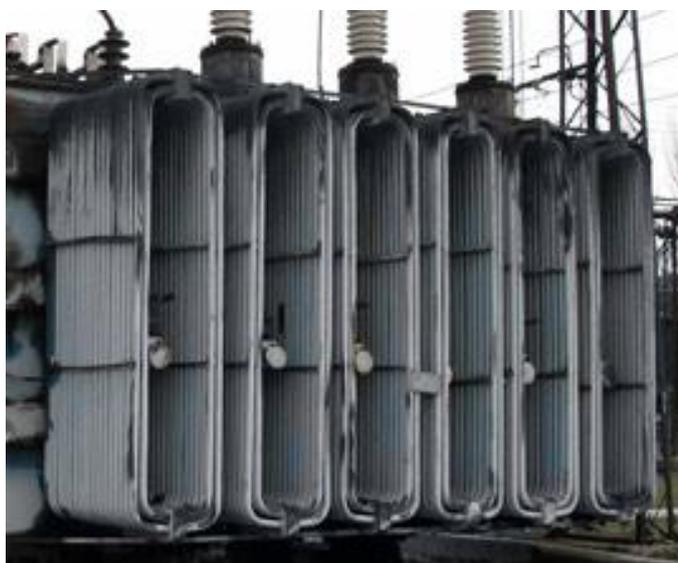
Рисунок 28 – Трансформатор с системой охлаждения Д
