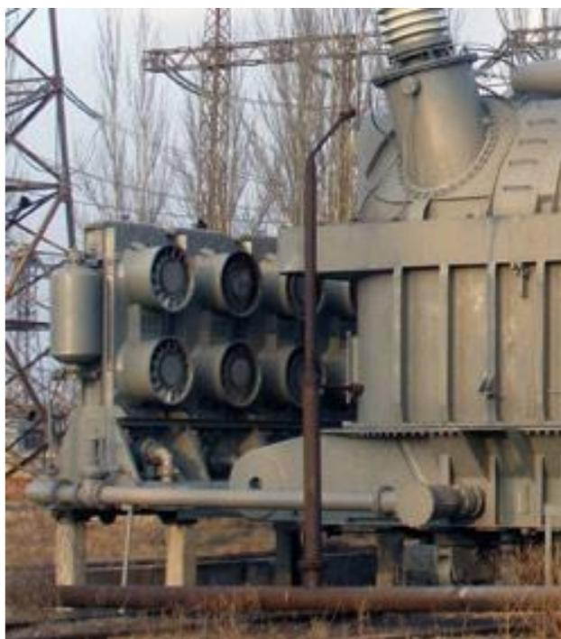
Рисунок 30 – Трансформатор с системой охлаждения Ц
