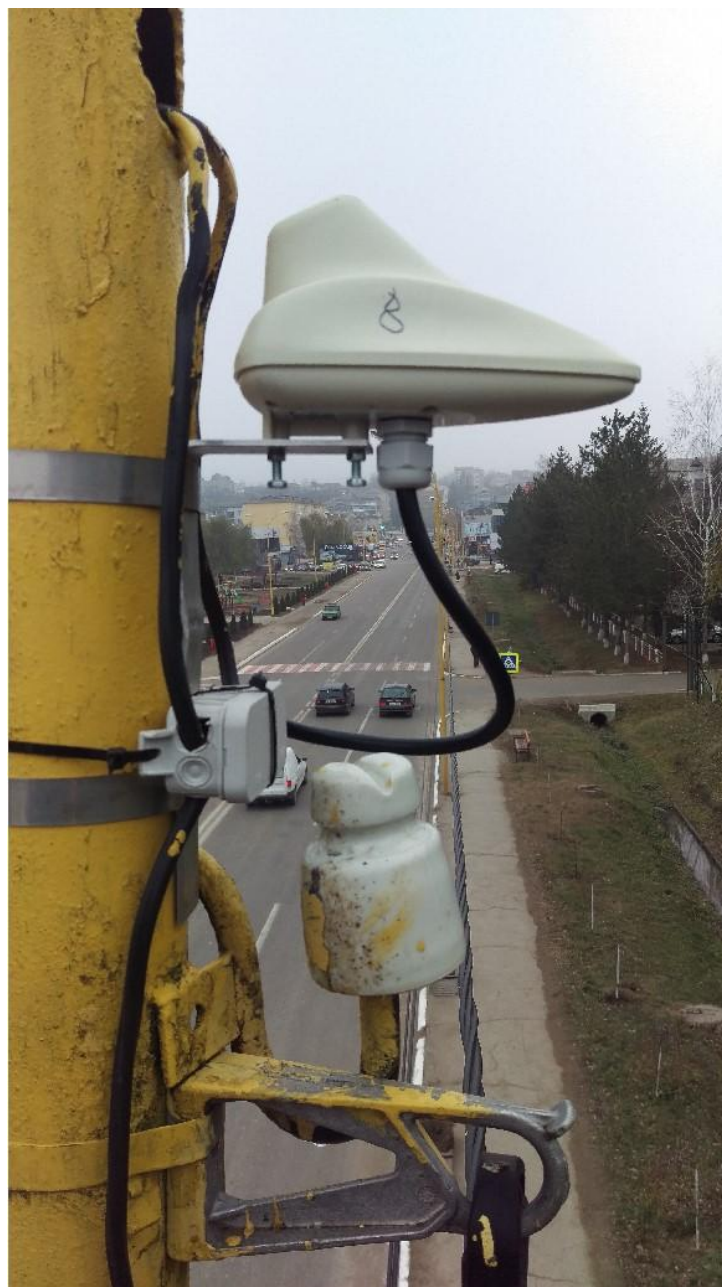
Рисунок 27 - Контроллеры уличного освещения FRE-220
