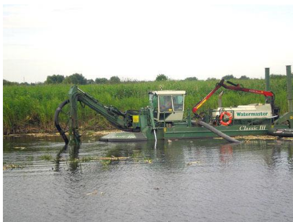
Рисунок 17 - Работа земснаряда по очистке водоема от ила
