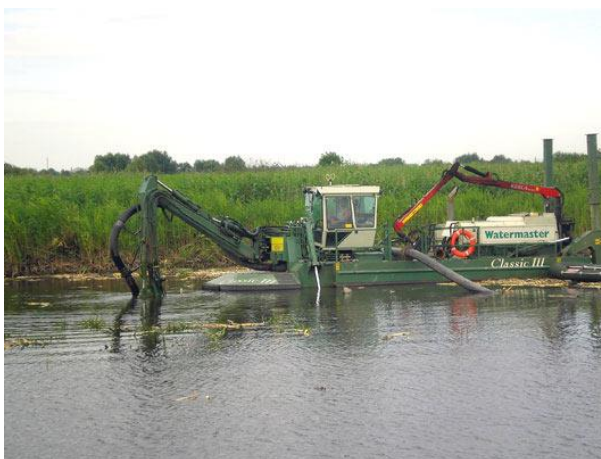
Рисунок 4 - Работа земснаряда по очистке водоема от ила
