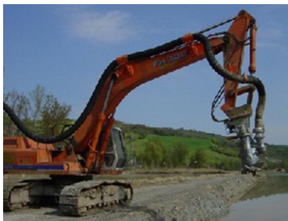
Рисунок 16 – Работа экскаватора по очистке водоема от ила
