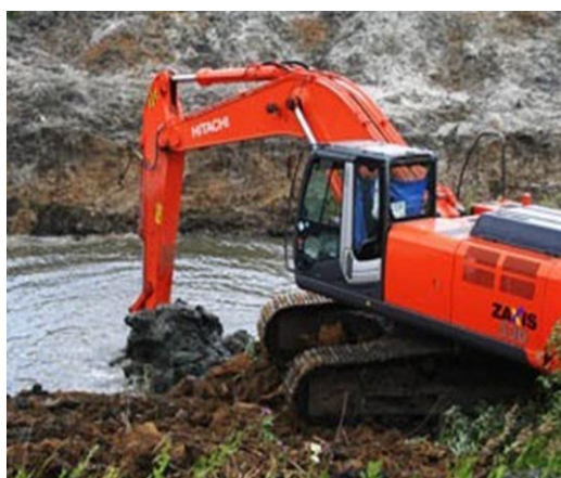
Рисунок 3 – Работа экскаватора по очистке водоема от ила
