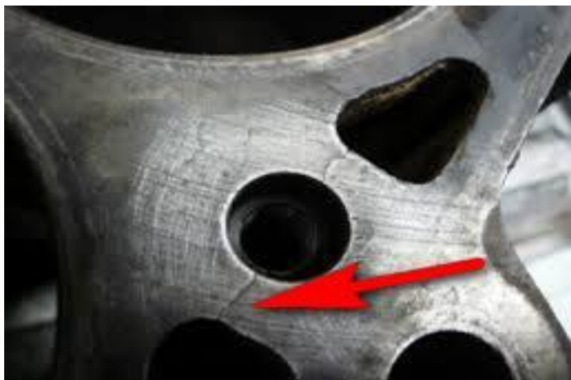
Рисунок 15 – Трещины в районе отверстий под болты
