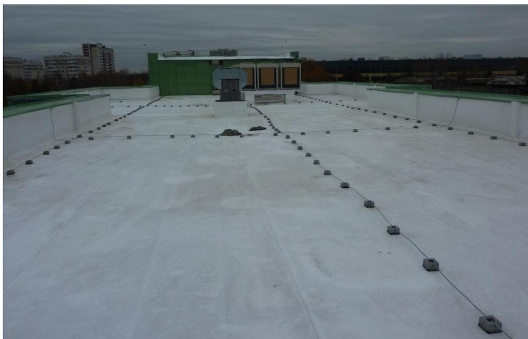
Рисунок 6 - Сетчатая молниезащита, выполненная на кровле объекта
