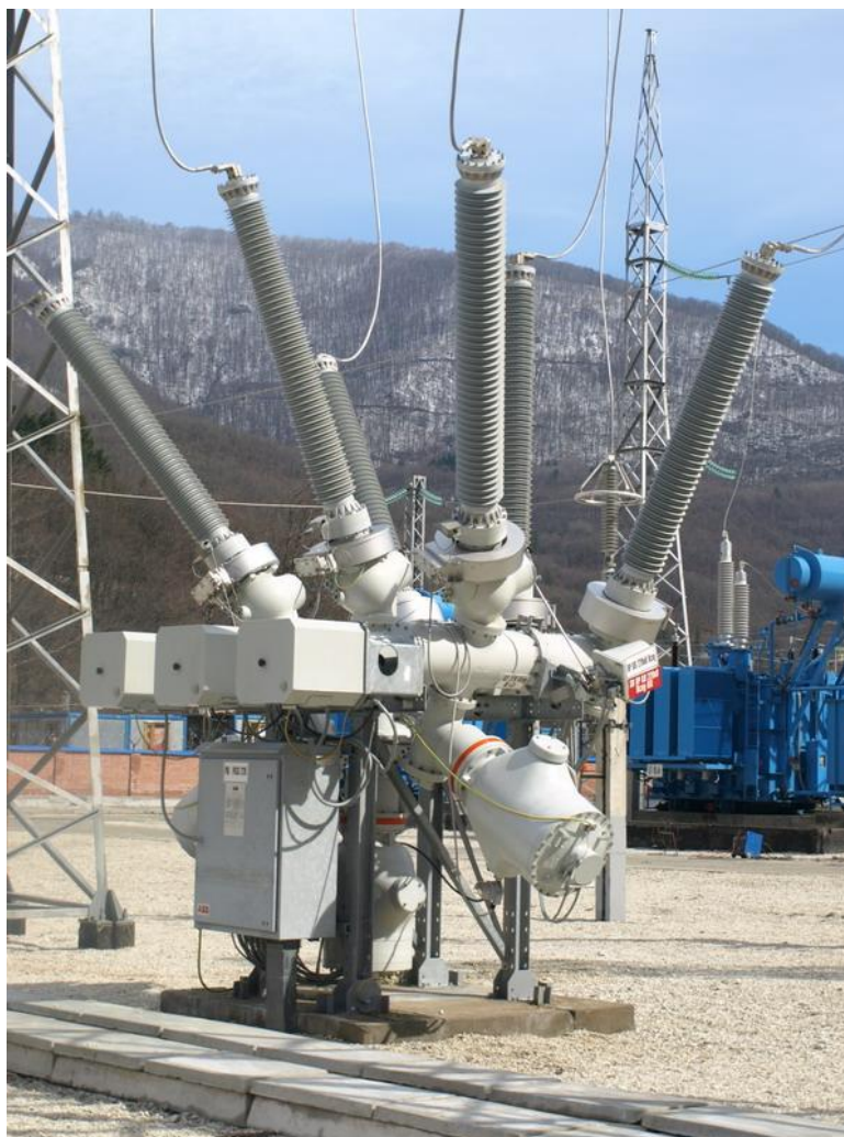
Рисунок 6 – Ячейка PASS MO производства ABB
