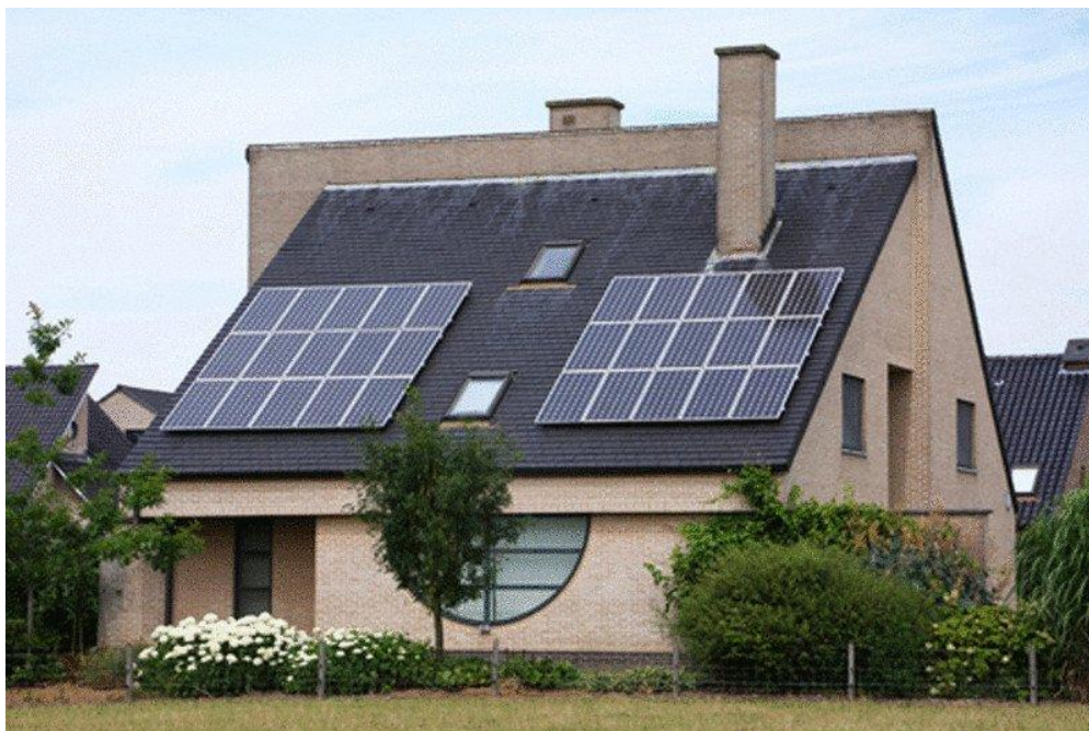
Рисунок 3.2 – Установка солнечных батарей на крышах коттеджей
