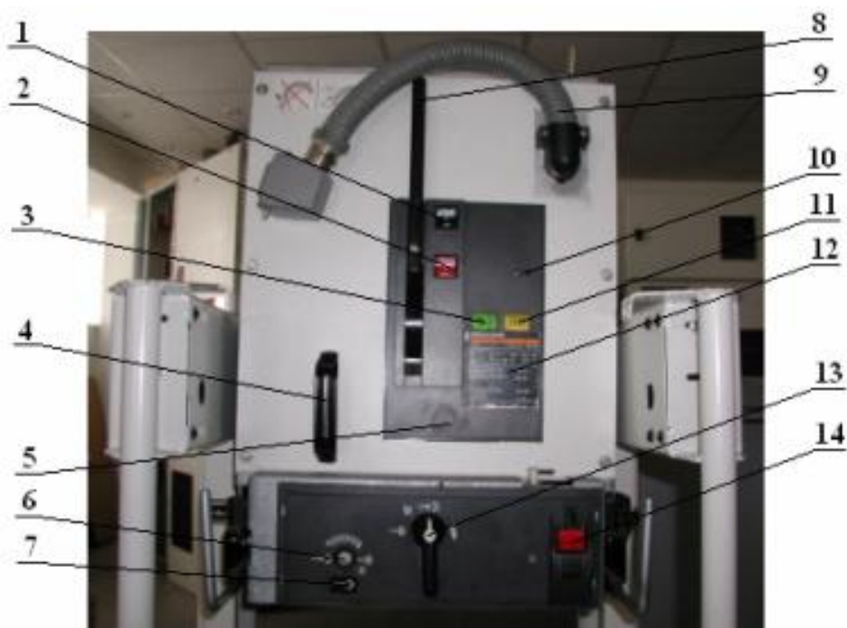
Рисунок 6.4 - Фото выключателя серии LF на выкатной тележке.
