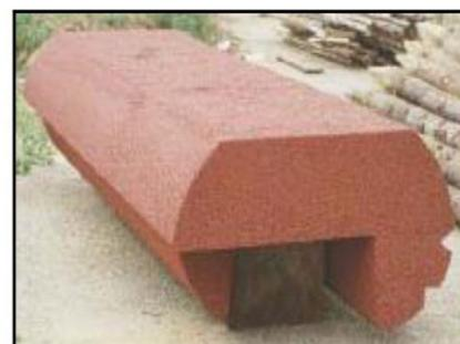
Рисунок 11 – Внешний вид верхней части шумозащитных экранов
