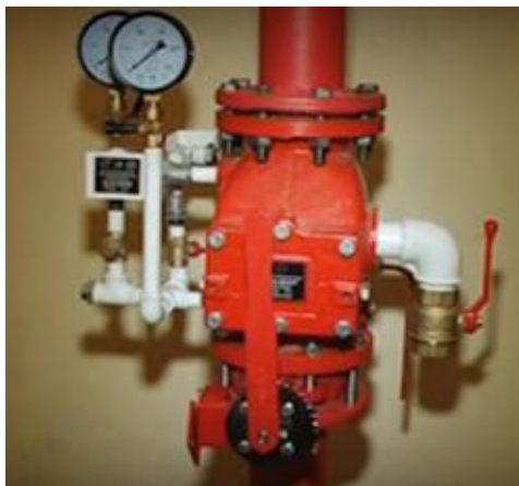
Рисунок 13 - Клапан пожаротушения
