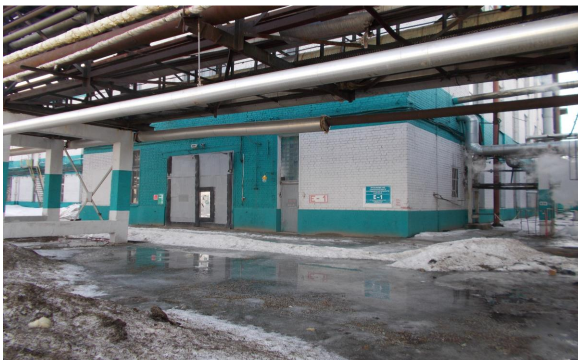
Рисунок 3 - Фото объекта (E-1)
