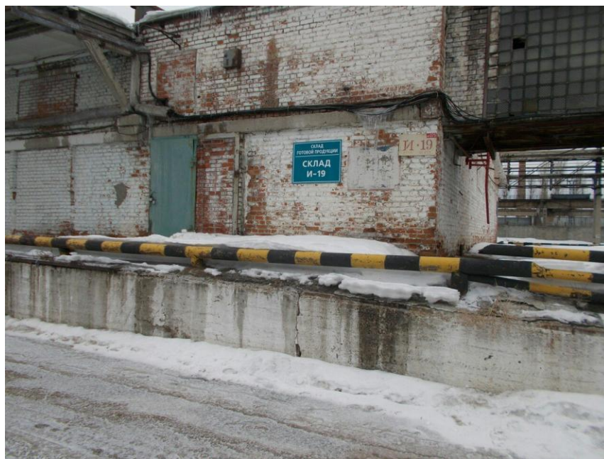
Рисунок 1.2 - Вид на фасад здание склада
