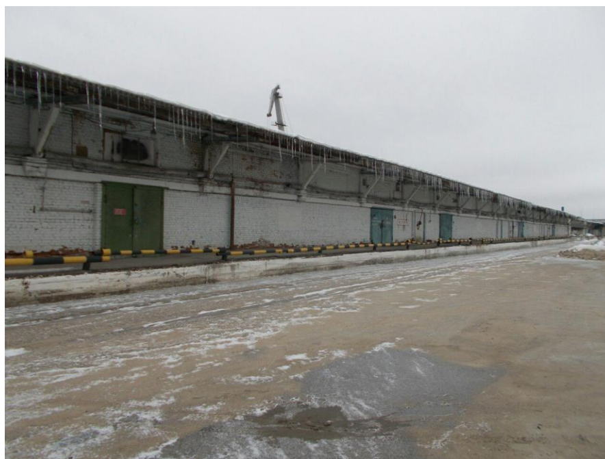
Рисунок 1.3 - Вид на здание склада
