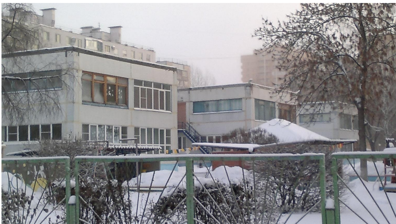
Рисунок 2 - Вид с восточной стороны
