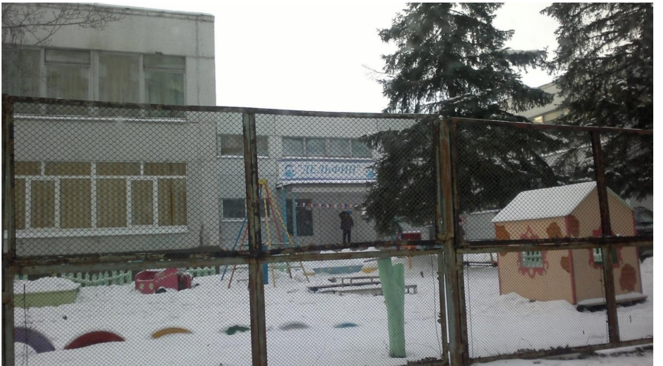
Рисунок 4 - Вид с северной стороны
