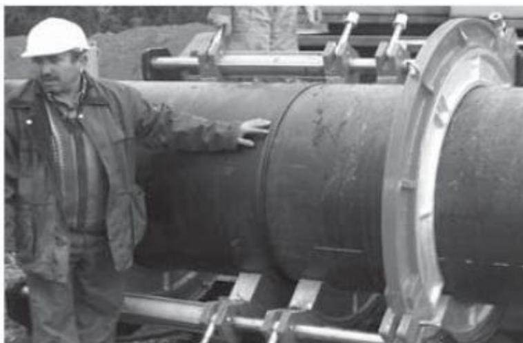
Рисунок 2.7 – Буртик при сварке полиэтиленовых труб
