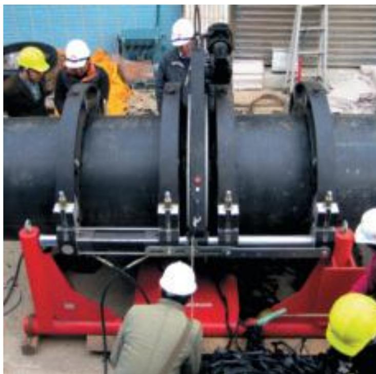
Рисунок 3.14 – Сварка магистрального трубопровода из полимерных труб при помощи машины Roweld P1200
